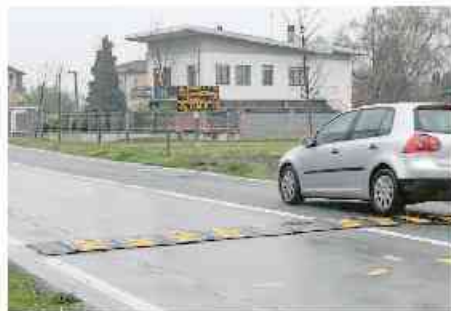
Un nuovo dissuasore in via Varallino
